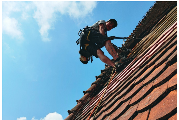
Benito Giacomo Zambelli bei der Dachreparatur
